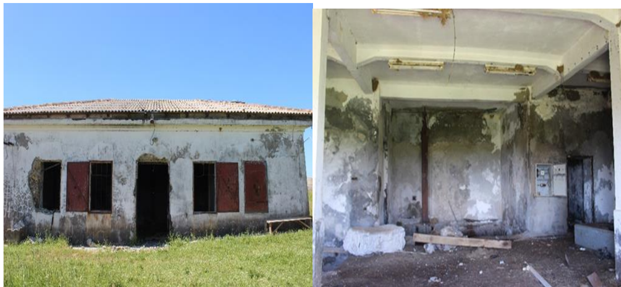
Slika 9. i 10. Stanje objekta pumpa 31 (foto Belma Šestović)
