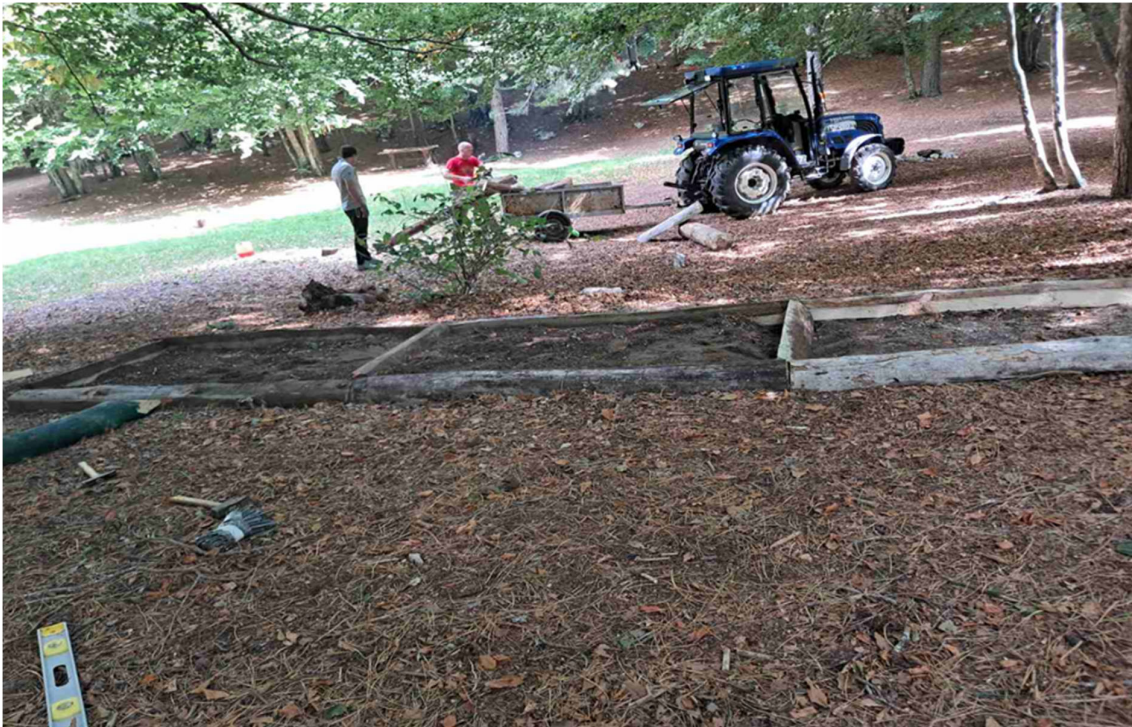
Slika 1: Radovi na uređenju staze za boso hodanje
